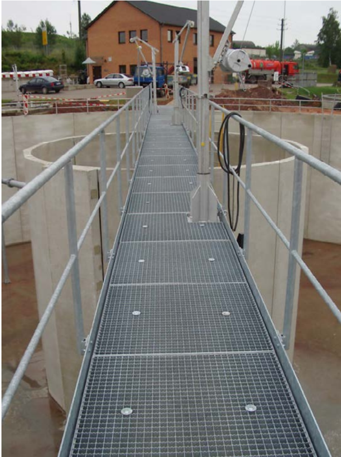
Gitterrostbrücke über ein Klärbecken mit Geländer Typ 1 aus Edelstahl (Wst.: 1.4301)
