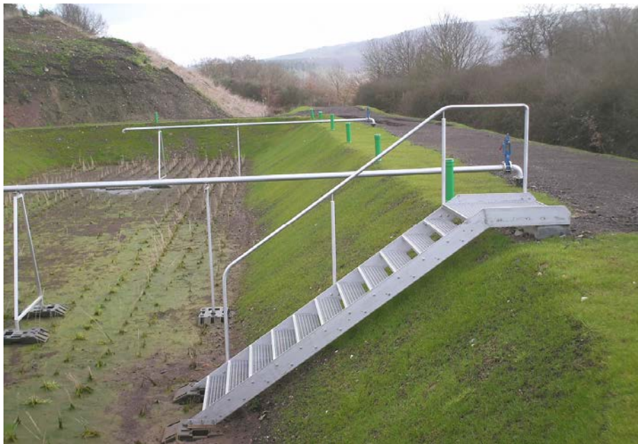
Treppe mit einseitigem Geländer aus Edelstahl (Wst.: 1.4301)
