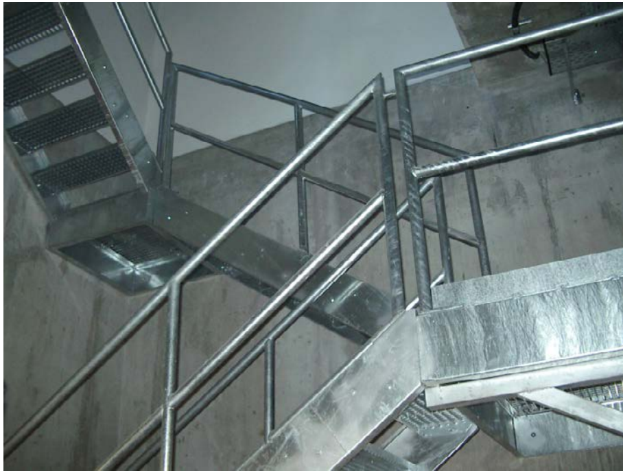
Treppe mit Geländer Typ 1 aus verzinktem Stahl
